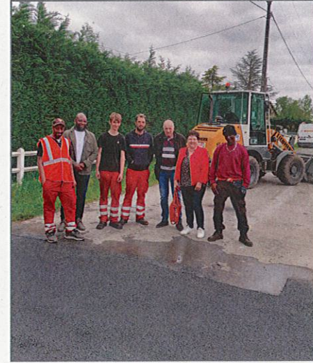
Travaux : une équipe mobilisée pour la sécurité routière. Lieu : Le Tronc
