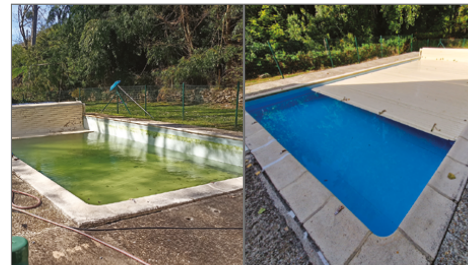
Changement du liner AVANT/APRÈS : Pour mieux accueillir les hôtes, la piscine du Gîte du Moulin a été entièrement restaurée. Le liner a été changé et les abords et installations de sécurisation révisés. Lieu : Gîte du Moulin
