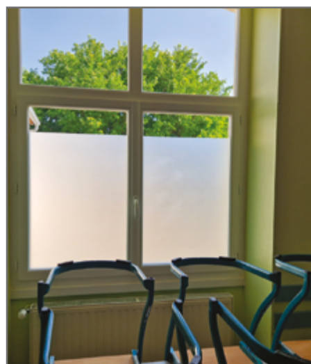
Film anti-chaueur et brise-vue : Les services techniques ont posé des film adhésifs sur les vitrages pour améliorer confort et intimité. Lieux : salle des fêtes et de la cantine
